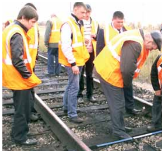
Специалисты осматривают устройства УКПС на перегоне Безречная–Хадабулак
