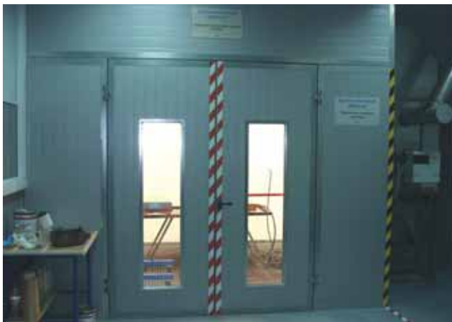
В окрасочно-сушильной камере ISB 18 зоны окраски и сушки совмещены
