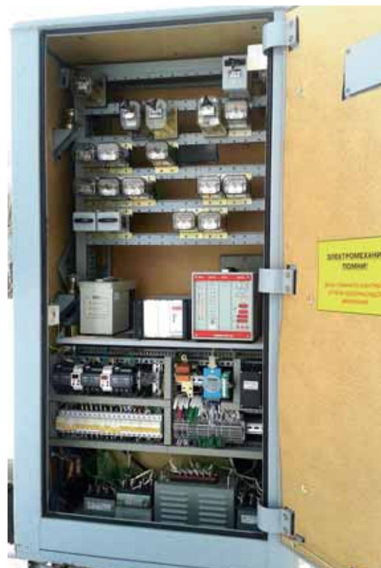
Релейный шкаф автоматической переездной сигнализации АПС-МП-М
