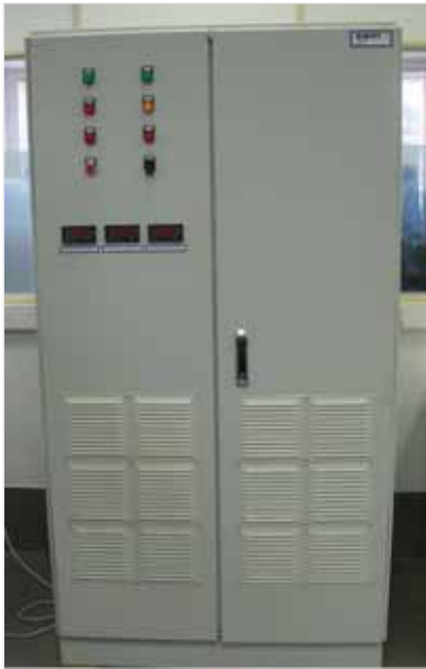
Панель шины постоянного тока
