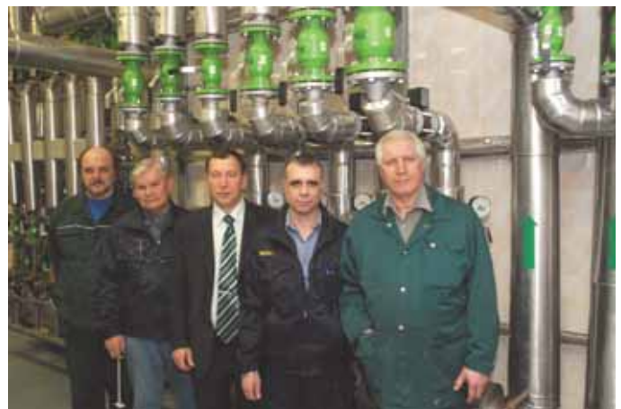
В тепловом узле – заместитель начальника отдела В.И. Горбылев (в центре), инженер Е.С. Калинин, электромонтер Ю.М. Васин, слесарь-ремонтник Г.Ю. Хохлов, электрогазосварщик А.А. Хороших
