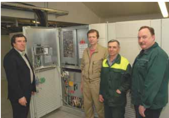
Главный энергетик А.А. Кельблер (слева), электромонтер С.В. Андреев, инженер В.Н. Плотников, старший диспетчер С.Е. Захаров во время осмотра установок электропитания
