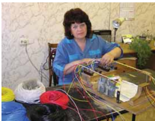
Электромеханик Т.М. Голубь изготавливает коммутацию для электроприводов
