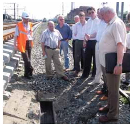
Участники школы заинтересовались новым методом прокладки кабеля – лотковой канализацией
