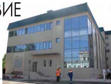
Новый пост ЭЦ станции Сызрань
