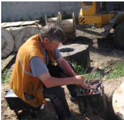
Прозвонка и расшивка кабеля в муфте
